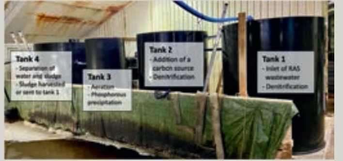
Şekil 1. Küçük ölçekli bir aktif çamur sistemi. Tank 1'de RAS'tan gelen atık su eklenir ve denitrifikasyon başlar. Tank 2'de denitrifikasyonun verimliliğini artırmak için çamur veya metanol gibi bir karbon kaynağı eklenir. Su ve çamur daha sonra fosforun çökeltildiği ve N 2 'nin havaya salınması için havalandırmanın eklendiği tank 3'e bırakılır. Son olarak, tank 4'te su ve çamur ayrılır ve çamur alınır veya tank 1'e geri gönderilir. Ardından artık çok daha düşük miktarda azot ve fosfor içeren su, bertaraf edilir.
