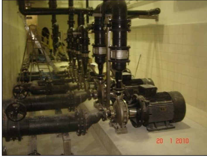
Şekil 6.18: Hamsu Besleme Pompaları
