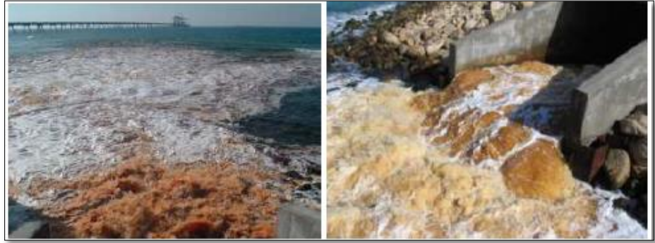
Şekil 5.22: Ashkelon SWRO tesisinden ön arıtmadan kaynaklı Fe^{+3} renkliliği
