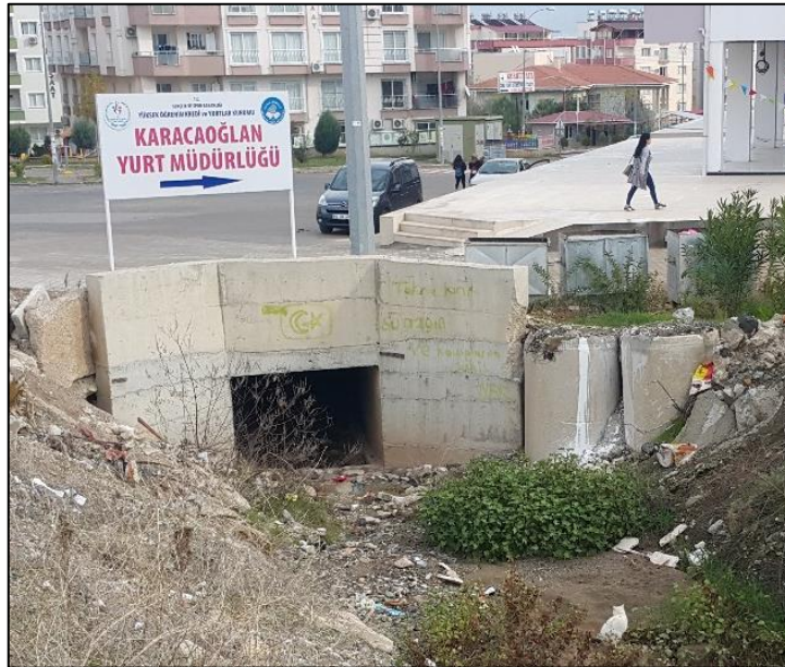
Fotoğraf 8 Toki Caddesi üzerindeki kapalı kesit girişi
