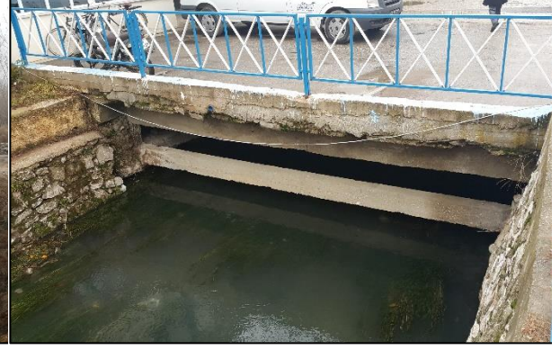
Mevlana Caddesi altındaki yol geçişi
