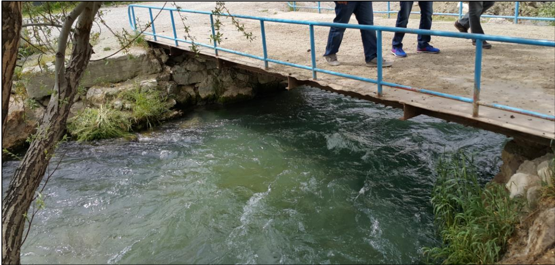
Fotoğraf 17 Dokuztay Mahallesi Yol Geçişi ve Dere Hattı
